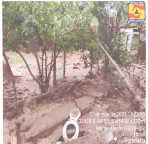
Travessa Laura Lins, o muro desabou pela força da enxurrada.
