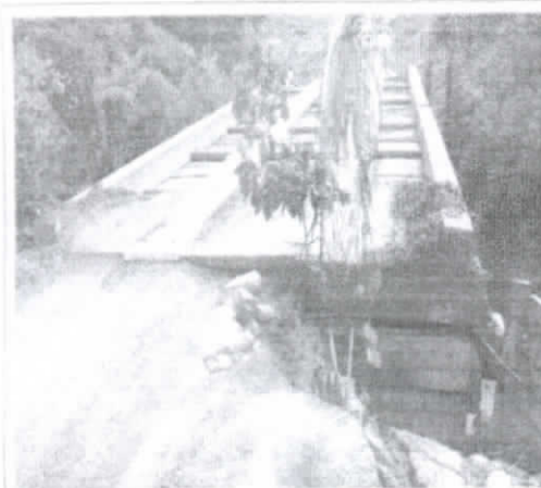
Ponte do setor 02
